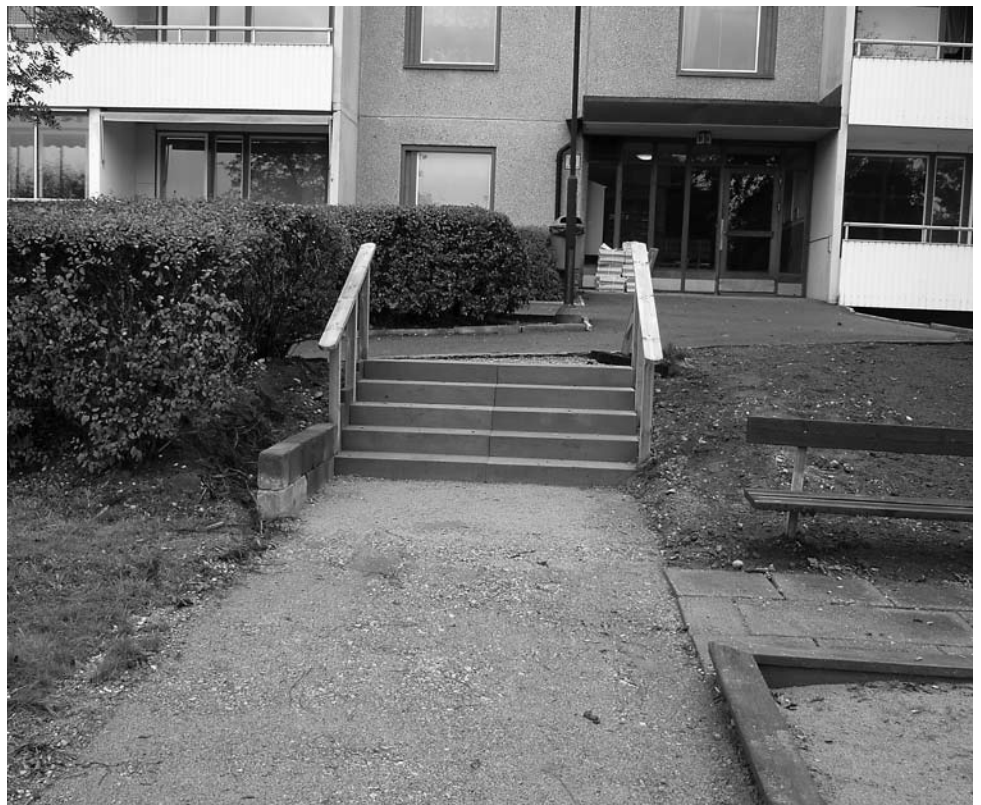
• Ny trappa på plats vid Gråbergsgatan 81
